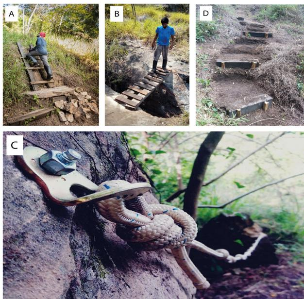
Figura 14 – Estruturas utilizadas nas trilhas de acesso aos setores de escalada. A - escada vertical com degraus; B - passarela elaborada; C - Corrimão de corda; D - degraus feitos diretamente no solo.
