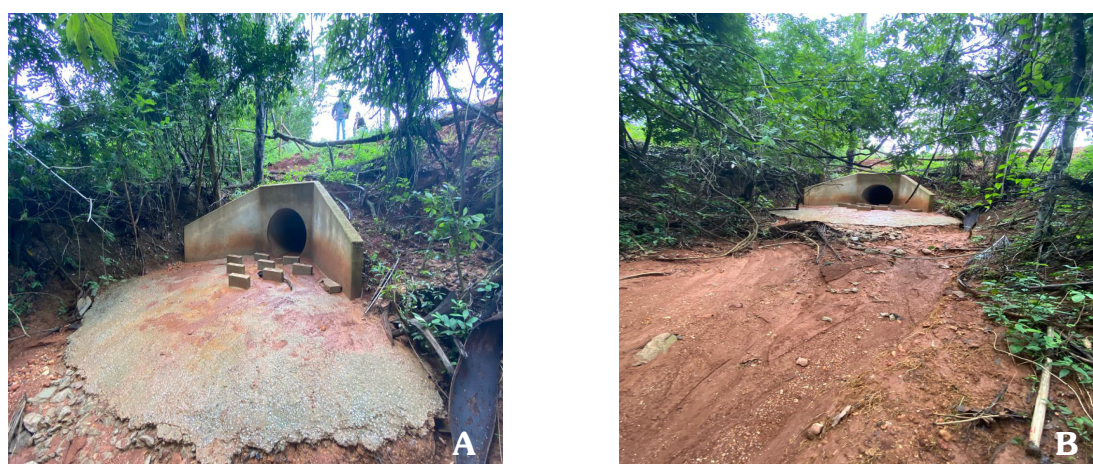
Figura 3 – Dissipadores de energia (A); e Sulcos erosivos evidentes (B). Fotos: Bárbara Dornela.
