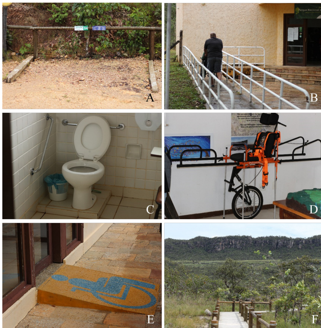
Figura 1 – Parque Nacional da Chapada dos Veadeiros. A) Estacionamento com vagas reservadas para pessoas com deficiência. B) Rampa de acesso ao centro de visitantes. C) Banheiro adaptado com barras de apoio. D) Cadeira Julietti. E) Rampa de acesso à área externa do centro de visitantes. F) Trilha suspensa com 230 metros para acesso ao Rio Preto.
