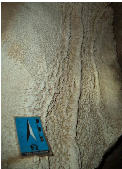
Figura 15 - Escorrimento ao longo da parede da caverna SJDR_HOL_010. (Fonte: Juliana Timo)
